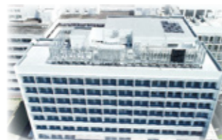
【新病棟 II 期棟外観】
