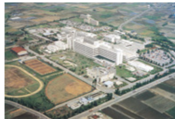
病院全景（昭和63年）
