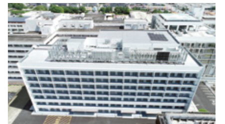
新病棟 (II期棟) 完成 (令和2年) Completed New Ward (Phase II) (2020)
