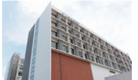
新病棟完成 (平成27年) Completed New Ward (2015)
