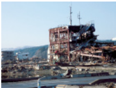
鉄骨のみが残った南三陸町防災庁舎
