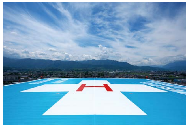
屋上ヘリポート
