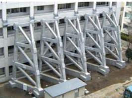
かねてより、大地震に備えての病棟耐震工事を実施していましたが、3月末に完成いたしました。外部にフレームを組み立て、4階床面を東西各10箇所のダンパーで支え、地震の揺れを抑えます。
