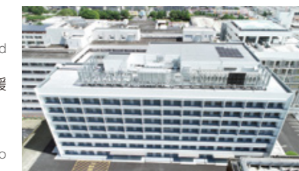
新病棟 (II期棟) 完成 (令和2年) Completed New Ward (Phase II) (2020)
