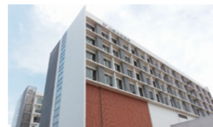
新病棟完成 (平成27年) Completed New Ward (2015)
