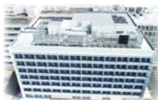
【新病棟 II 期棟外観】
