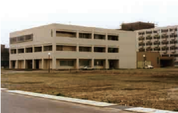
管理棟（昭和57年）
