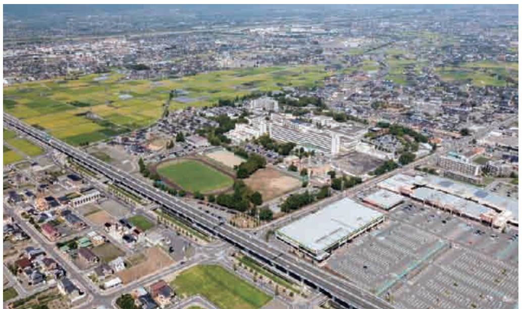
新病棟建築中の風景 (平成25年)
