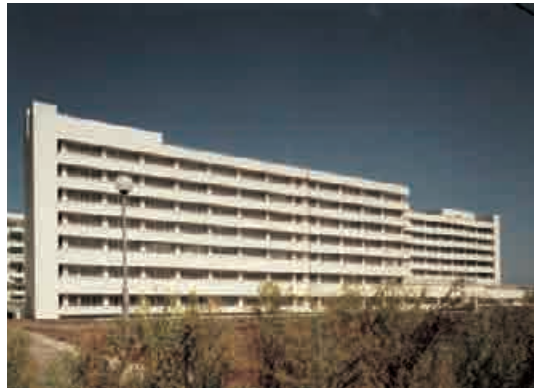
西病棟（昭和59年）
