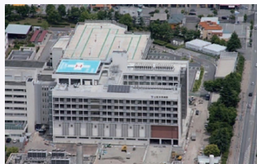
南北病棟（Ⅰ期棟）外観
