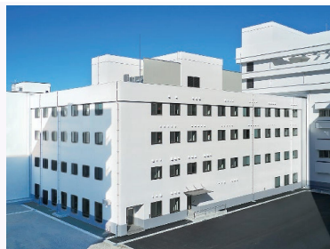
診療支援棟（Ⅲ期棟）外観
