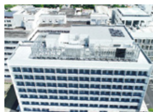
【新病棟 II 期棟外観】
