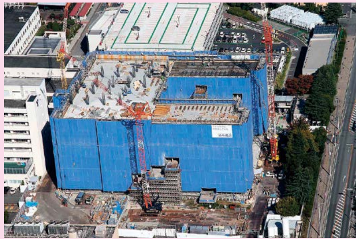
病棟南側上空から撮影 (平成 26 年 10 月 30 日)
